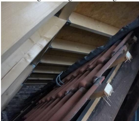
gelingt es uns, das alte Dach so lange aufrechtzuerhalten, bis die neue Dachhaut installiert war. Und das ohne Wasserschäden! Eine Herangehensweise, die dem Bauherren etwa 20.000 € für ein Wetterschutzdach ersparte.
