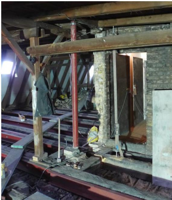
In der Schnittstelle Bestand (Gebäude Baujahr 1890) und Neubau des Dachgeschosses (KfW 70) ist eine Verbindung von ingenieurhafter Herangehensweise z.B durch statische Berechnungen des Daches mit handwerklichem Know-How notwendig. Weder lässt sich der Neubau vorab exakt auf den Bestand planen, noch kann das Handwerk die komplexen Materialverbünde aus neu und alt ohne Berechnungen z.B. der Bauphysik bewerkstelligen.
